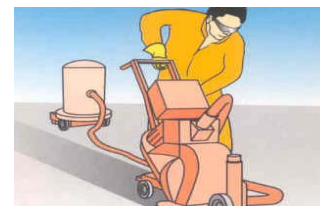
Przygotowanie podłoża: śrutowanie lub inny mechaniczny sposób, np. Blastrac.
