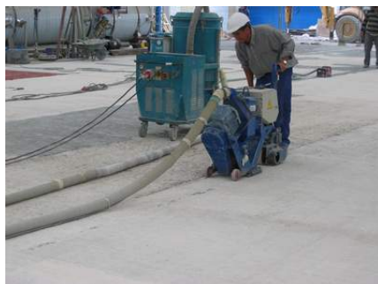
Śrutowanie z odpylaniem odkurzaczem
