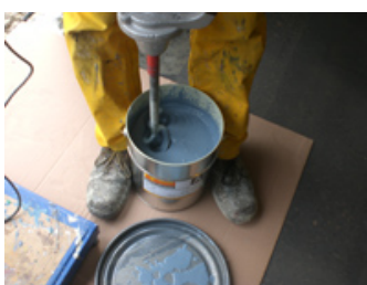
Mieszanie Sikafloor®-304 W lub -305 W
