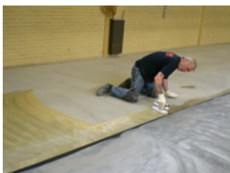
Sikafloor®-Comfort Adhesive po wylaniu należy równo rozprowadzić pacą zębatą używaną w pozycji klęczącej.
